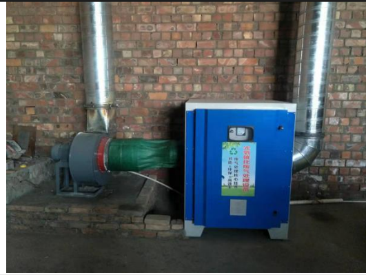
图 3-6 UV 光解催化废气净化器
