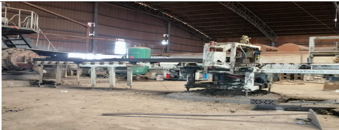
图 3-7 全封闭原料处理车间
