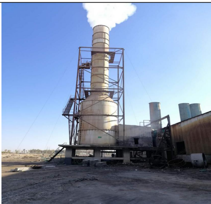
图 3-9 脱硫除尘装置 25m 高，内径 3m
