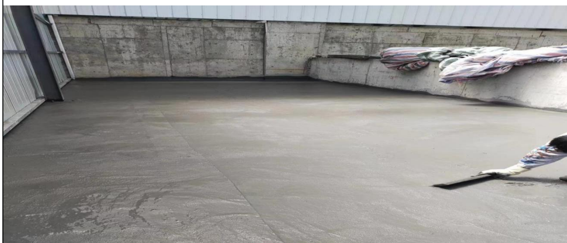
图 3-17 危废间施工图片
