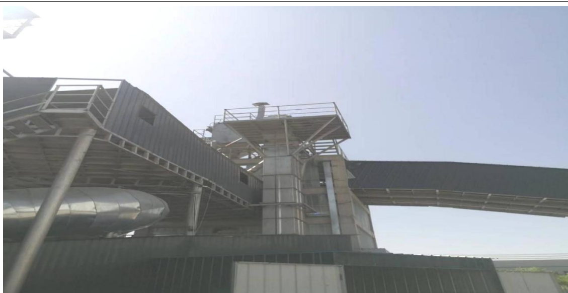
图3-5 破碎筛分废气排气筒
