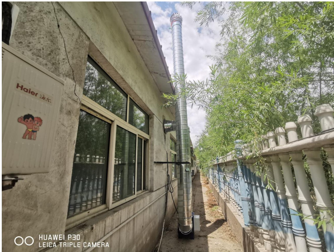
图 3-9 油烟净化器+排气筒
