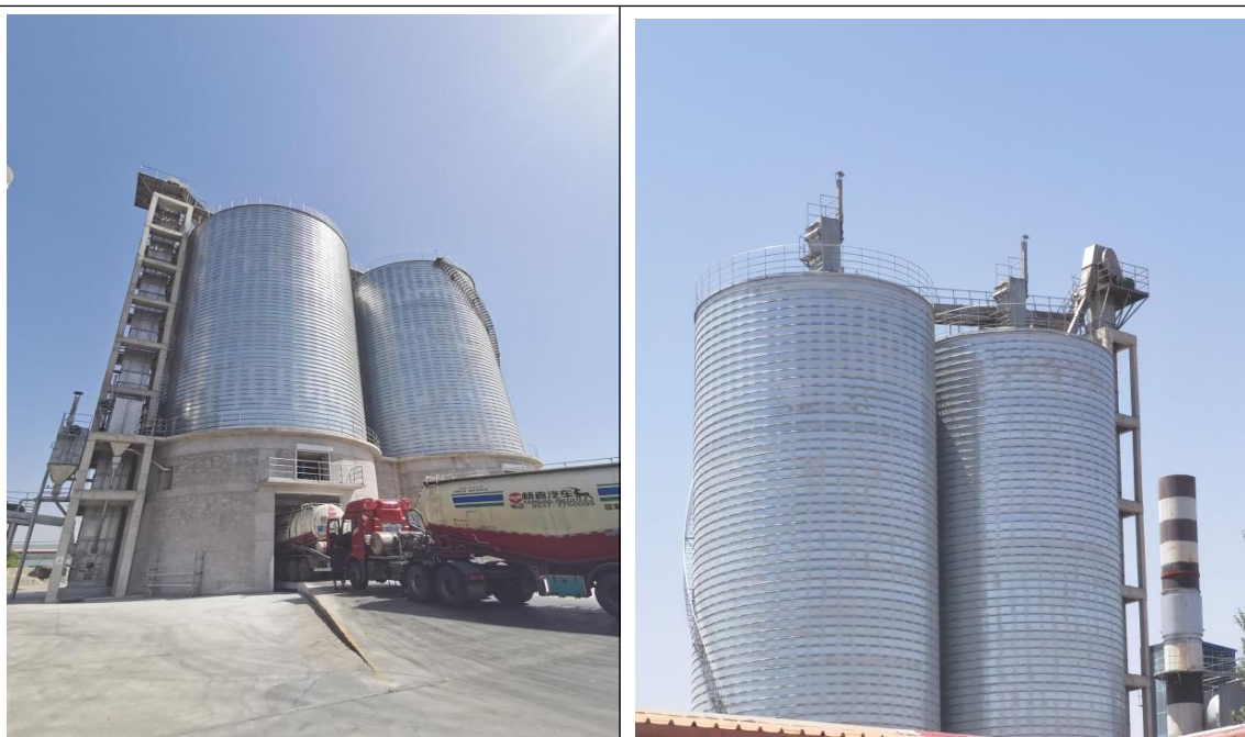
图3-8 成品仓及其仓顶排气筒
