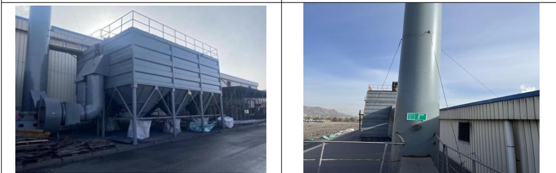
图 4-4 熔硅除尘设施（布袋除尘器+15m 高排气筒）
