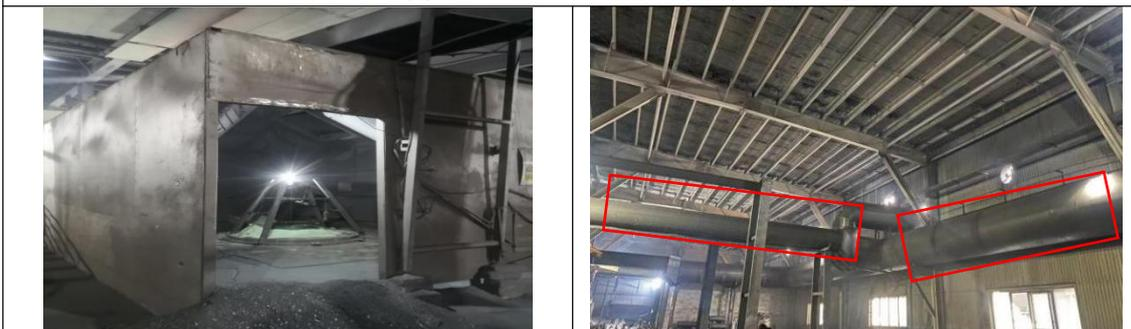
图 4-2 熔硅集气罩
