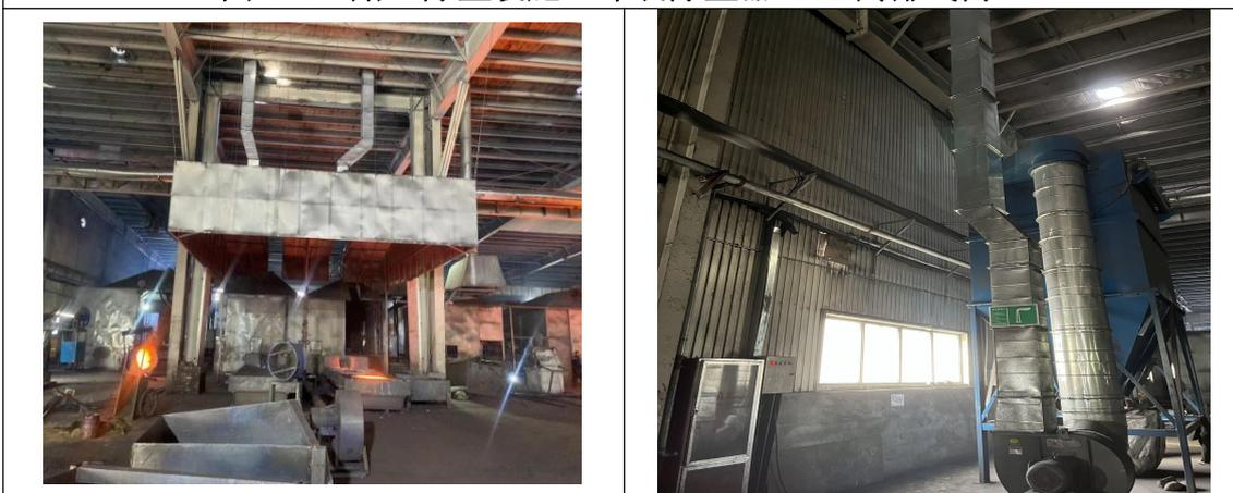
图 4-5 转运、浇注区上方设置集气罩+布袋除尘器及排气筒
