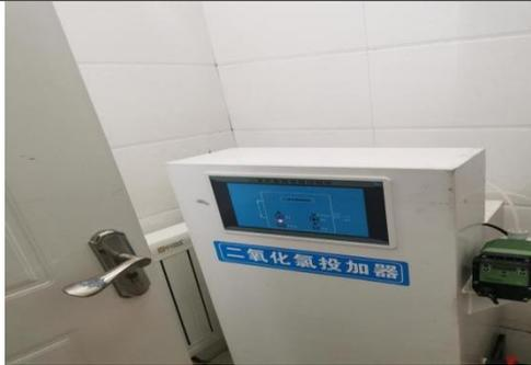
图 3-5 污水处理站二氧化氯投加器
